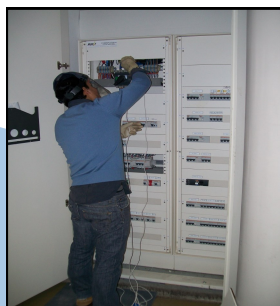
Pose de matériel d'enregistrement des flux
